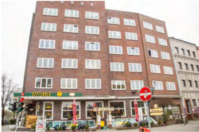
Versteckter Eingang unter dem „September“
